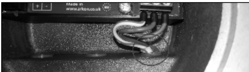
Imagen 4: Verificar si el pasacables se ha rellenado satisfactoriamente con el estándar IP68
