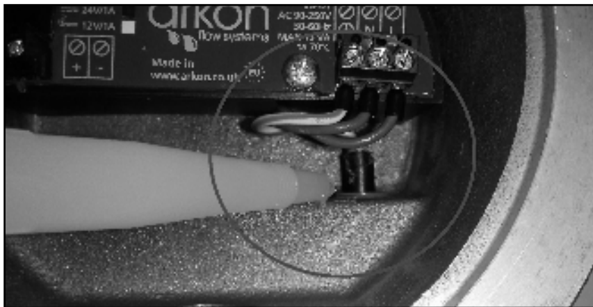
Imagen 2: Aplicación de la silicona en la funda del extremo del cable cruzado de corte redondo
