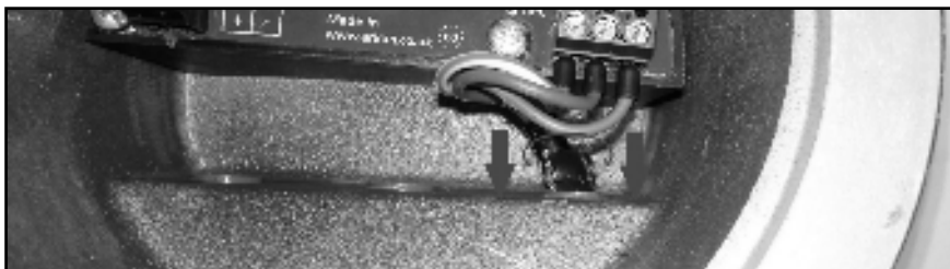
Imagen 3: Manipulación del cable para lograr el suficiente relleno del pasacables
